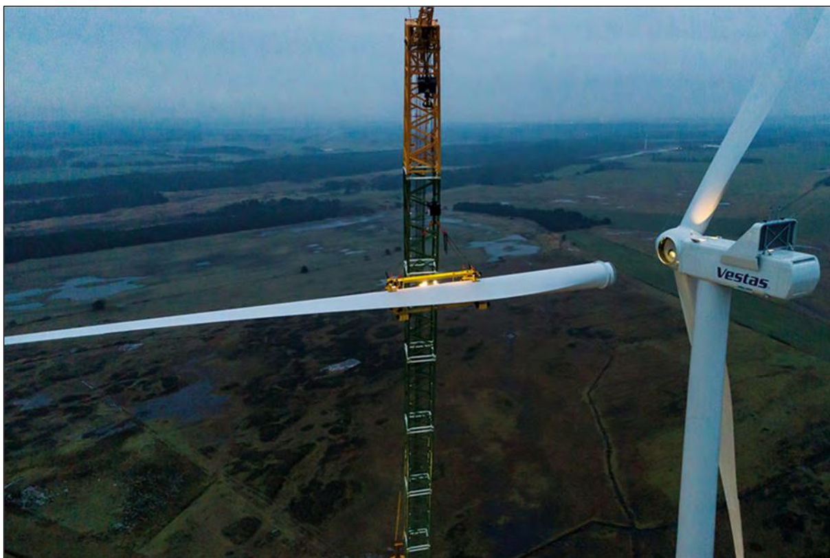
Obrázok 6: Výstavba veternej elektrárne – montáž listov
