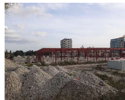
Pohľad na západ - existujúca zástavba
